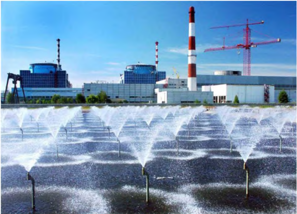
Відокремлений підрозділ “ХАЕС” Бризкальні басейни
